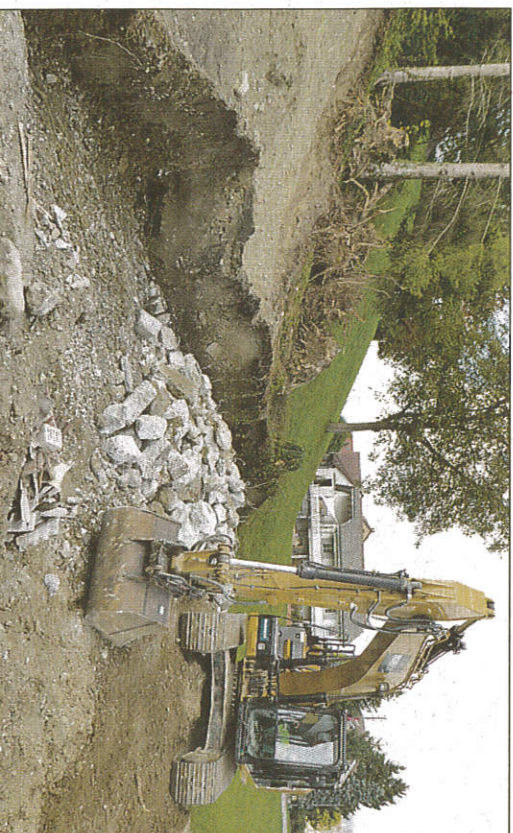
Sanierung des Geländes vom Hallwiler Schiessstand. Nach dem Abtragen der Humusschicht wurde die Bleibelastung im Boden gemessen, bis sicher gestellt war, dass kein verseuchtes Erdmaterial mehr vorhanden war. (Bilder: aw.)
