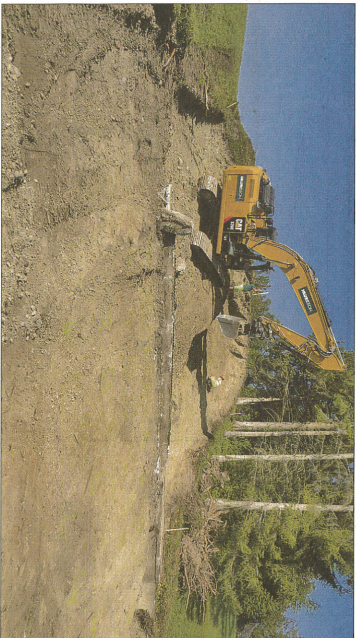
Sanierung des Geländes vom Hallwiler Schiessstand. Nach dem Abtragen der Humusschicht wurde die Bleibelastung im Boden gemessen, bis sicher gestellt war, dass kein verseuchtes Erdmaterial mehr vorhanden war. (Bilder: aw.)
